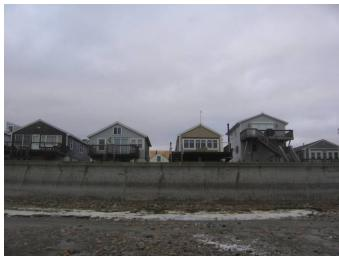
PHOTOGRAPH 10 - WALL ELEVATION STA 108+00 ERODED BEACH
