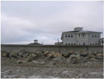
PHOTOGRAPH 13 - RIP RAP AT WALL "BOW" STA 118+00 ERODED BEACH
