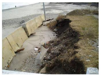
PHOTOGRAPH 37 - EROSION OF AREA BEHIND BLOCKS
